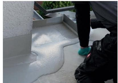
Der Verlaufmörtel Wecryl 337 bildet die Schutzschicht der Abdichtung. Er wird mit der Aufstreichkelle mit Dreieckzahnleiste aufgebracht.
