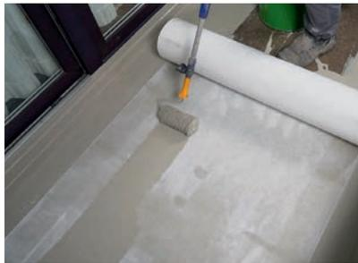
Auf der Bodenfläche kommt die vliesarmierte Flüssigabichtung Wecryl R 230 zum Einsatz und sorgt für eine nahtlose Flächenabdichtung.
