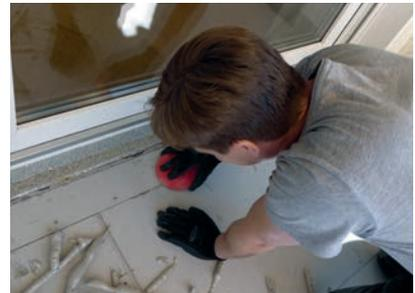
Der unbedingt einzuhaltende Abstand zwischen aufgehenden Bauteilen und den fermacell® Powerpanel TE-Platten von 5 mm wird mit PU-Kleber ausgeschäumt.
