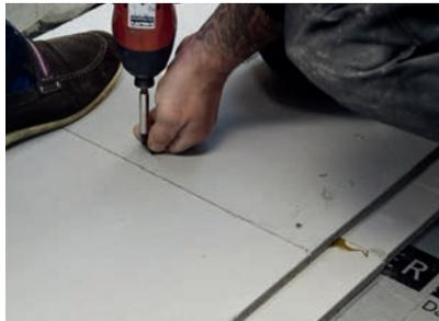
Mittels fermacell® Estrichkleber und fermacell® Powerpanel Schrauben werden die Platten untereinander befestigt.
