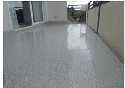
Das WestWood® Wecryl Abdichtungssystem hält die Balkone dauerhaft dicht und ist regelkonform nach DIN 18531-5.
