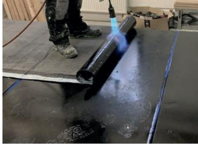
Zum Schutz der Dämmung vor Feuchtigkeit wird zunächst eine Dampfsperre aus Bitumenbahnen aufgebracht.
