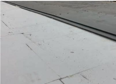
Als lastverteilende Schicht wird die fermacell® Powerpanel TE eingesetzt. Die zementgebundenen Platten werden vollflächig verklebt.
