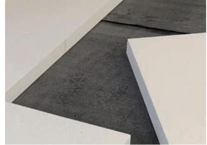
Die eingesetzte Dämmung weist die Einstufung DAA auf (Außenbereich) und hat eine Druckfestigkeit von 150 kPa. Sie wird vollflächig verklebt.
