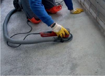
Durch Schleifen wird der Untergrund sorgfältig für das nachfolgende System vorbereitet.
