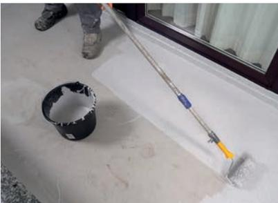
Im Anschluss wird die farbige Versiegelung Wecryl 488 vollflächig appliziert.
