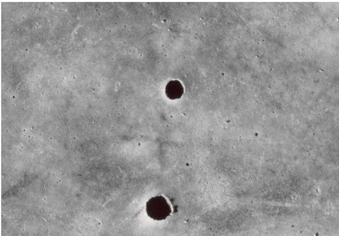
**Abb. 2: Poren in der Oberfläche der Abdichtung (Detail)**
