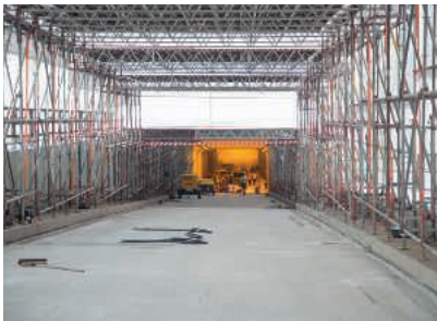
Nach dem Abfräsen der Fläche bis auf den tragfähigen Konstruktionsbeton wurde intensiv kugelgestrahlt.
