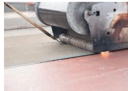
Mit einem handgeführten Verlegegerät erfolgte das Aufschweißen der Polymerbitumen Schweißbahn.
