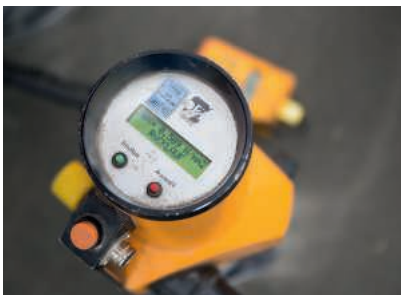
Die Haftzugprüfung der Bitumenschweißbahn bei der vorherrschenden Bauteiltemperatur erzielte mit über 0,5 N/mm 2 einen deutlich über der Norm liegenden Wert.
