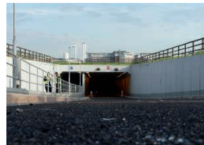
In einem Monat wurde das Trog- und Tunnelbauwerk instand gesetzt, der PMMA-Systemaufbau erfolgte in nur einer Woche.
