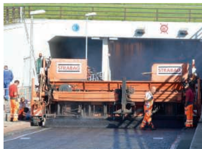
Es folgte der Einbau der Gussasphalt-Schutzschicht an den Randstreifen und der gesamten Fläche.
