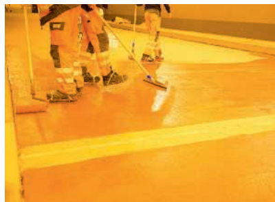
Als dritte Lage wurde die Versiegelung Wecryl 123 mit dem Gummischieber verteilt und mit der Fellrolle bearbeitet.
