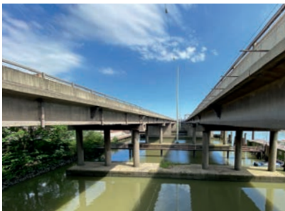
Auf dem 3,8 km langen K20-Abschnitt der Bundesautobahn 7 wurden die Riegeloberseiten beschichtet.
