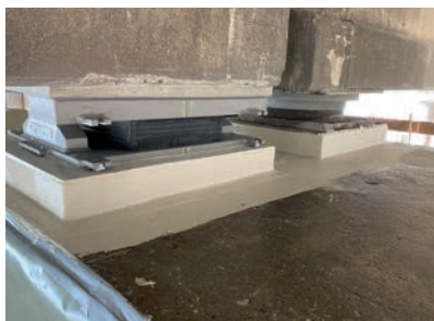
Details wie die Riegel-Randaufkanten und die Podeste der Brückenlagerkonstruktionen wurden mit Wecryl R 230 thix mit Weplus Vlieseinlage abgedichtet.
