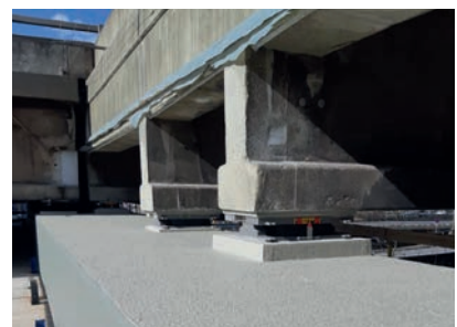
Mit dem Wecryl Oberflächenschutzsystem OS-F (OS 11b) und dem BIS-Mörtel Wecryl 885 wurden die Vorgaben der ZTV-ING Teil 3 Abs. 4 vollständig erfüllt.
