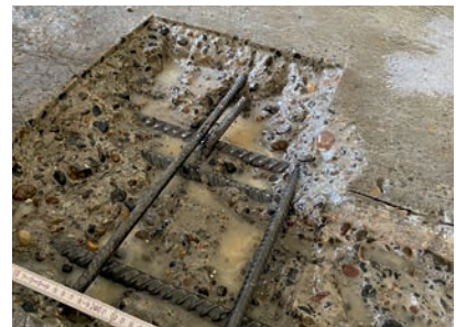
Die Schäden der Betonoberflächen erforderten partielle Abbrüche bis hinter die Bewehrung. Grundierung und Korrosionsschutz erfolgten mit Wecryl 276.
