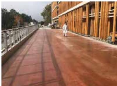
Die kugelgestrahlten Betonoberflächen wurden mit Wepox 120 als erste Versiegelungslage grundiert und mit Quarzsand abgestreut.
