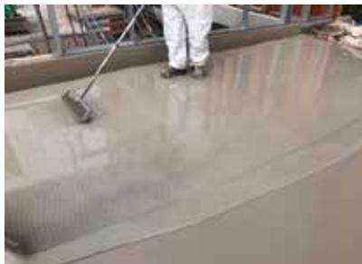
Nach Aushärtung der ersten Lage Wecryl 274 folgte eine zweite Schicht mit der erforderlichen Mindestschichtstärke von 1,6 kg/m<sup>2</sup>.
