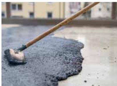
Die Temperatur des Gussasphaltes bei dem Erstkontakt mit dem WestWood Tack-Harz beträgt ca. 220 °C - 230 °C.
