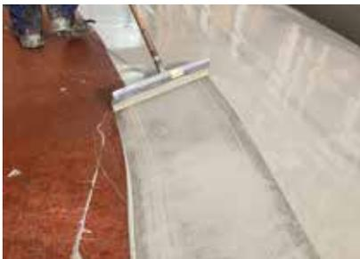
Die erste Lage der Wecryl 274 Abdichtungsschicht wurde mit dem Zahngummirakel aufgezogen und mit dem Stachelroller entlüftet.
