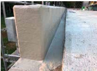
Nach der entsprechenden Untergrundvorbereitung der Details wurden diese vliesarmiert mit dem Wecryl 274 thix abgedichtet.
