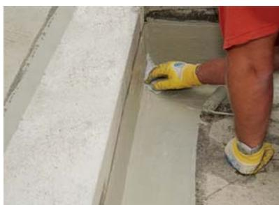
In der Ecke kommt eine zusätzliche Vlieseinlage, die ebenfalls nass-in-nass eingearbeitet wird.
