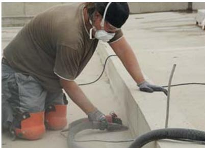
Betonschlämme an den Fugenflanken mittels Diamantschleifer entfernen. Danach sind die Beschichtungsf lächen zu reinigen und zu entstauben.
