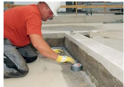
Das fixierte Fugengleitband sorgt dafür, dass die Bewegung aus dem Untergrund dauerhaft sicher überbrückt werden kann.
