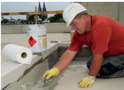
Einbettsschicht aus PMMA-Harz Wecryl R 230 satt aufbringen.
