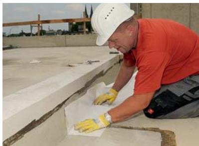
Den passend zugeschnittenen Vliesstreifen blasenfrei einarbeiten. Er verleiht dem System seine rissüberbrückende Eigenschaft.
