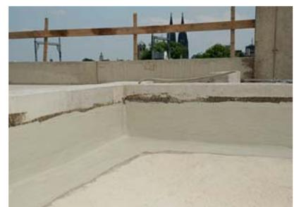
Fertig ist das naht- und fugenlose Abdichtungssystem, das laut ETA in Kategorie W3 eingestuft ist (Lebensdauer > 25 Jahre).
