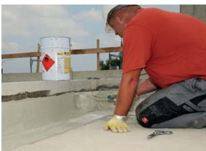
Das Vlies nass-in-nass mit Wecryl R 230 sättigen. Es dient zur Schichtdickenkontrolle und sorgt so für eine hohe Verlege-Qualität.
