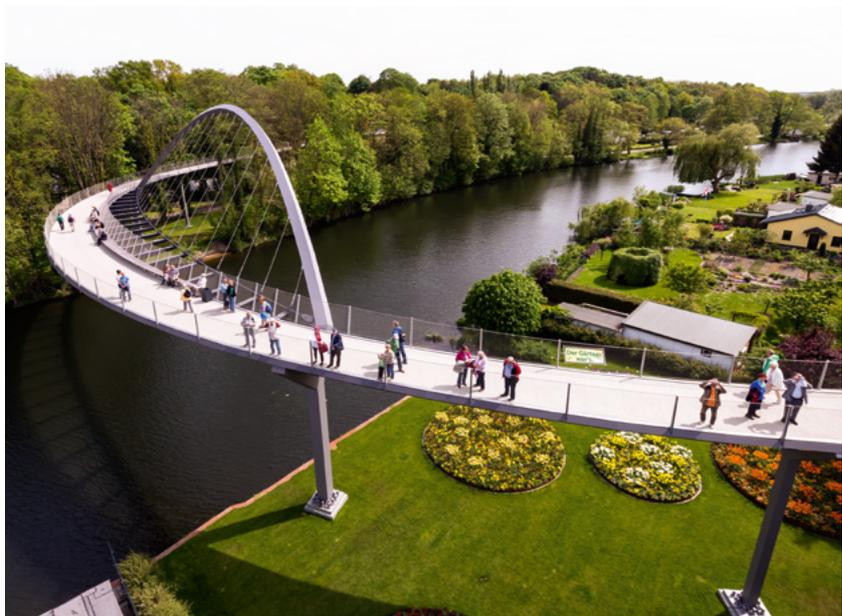
Die 348 Meter lange, s-förmig geschwungene Weinberg-Brücke verbindet über die Havel die Bundesgartenschauareale Optipark und Weinberg auf kurzem und dauerhaft sicherem Wege.
