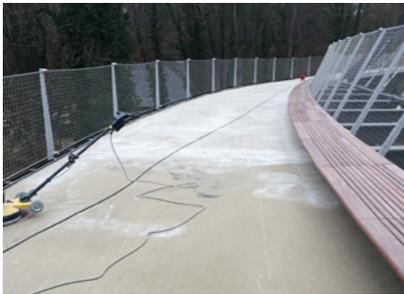
Der kugelgestrahlte Beton wurde grundiert und mit einer Kratzspachtelung versehen. Diese wurde zur Erzielung einer ebenen Fläche anschließend angeschliffen.
