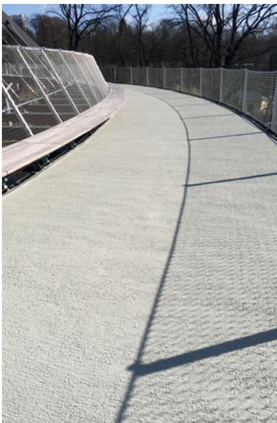
Pünktlich bis zur Eröffnung im April konnten die Verlegearbeiten des ca. 8 mm dünnen und ca. 12 kg/m<sup>2</sup> leichten Abdichtungssystem abgeschlossen werden.
