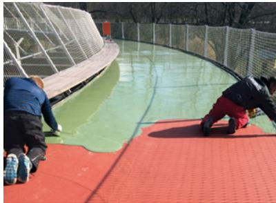
Fachverleger trugen die zweilagige, vlieslose Flächenabdichtung auf. Diese durch ein abP zertifizierte Abdichtung überbrückt Risse bis zu 1 mm sicher.
