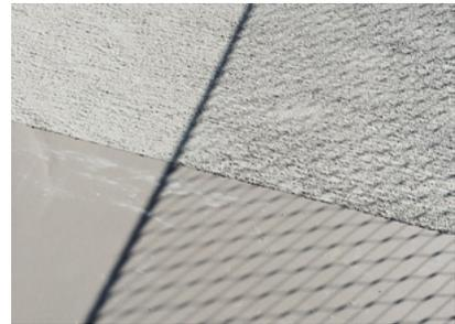
Im weiteren Aufbau schützt ein Verlaufmörtel (vorne) die Abdichtung vor Punktlasten und ein Strukturbelag (hinten) sorgt für eine hohe Rutschhemmung und Trittsicherheit.
