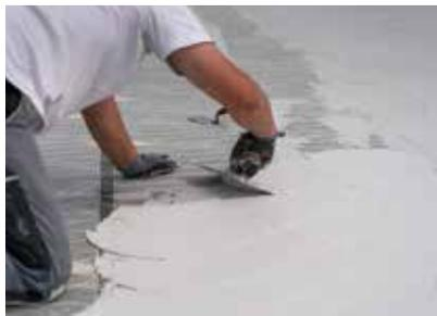
Die vollständige Einbettung der Heizmatten erfolgte mit dem Klebe- und Armierungsmörtel Wecryl 847.
