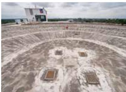
Die gesamte Asphalt-Fläche des Heliports wurde mit Wecryl 110 grundiert.
