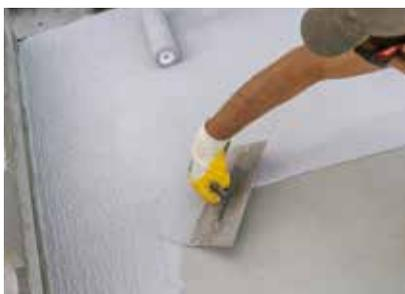
Die finale Nutzschicht bildete der Strukturbelag Wecryl 410. Dieser erfüllt u. a. die hohen Anforderungen der Rutschsicherheitsklasse R12.
