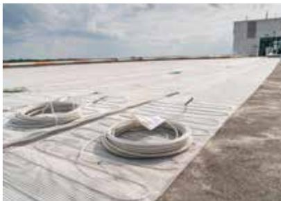
Das Heizsystem wurde gemäß den Vorgaben angeschlossen und in die Zentralsteuerung des Gebäudekomplexes integriert.
