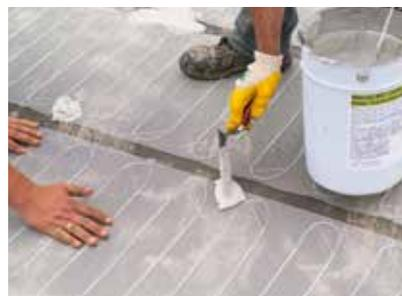
Zur Lagesicherung der Heizmatten wurden Heftpunkte gesetzt.
