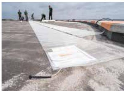
Direkt auf die Grundierung rollten die Fachverleger gemäß dem zugehörigen Verlegeplan die Netzheizmatten aus.
