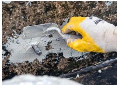
Kleinere Ausbrüche und Lunker wurden mit dem PMMA-Spachtel egalisiert.
