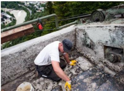
Die von den alten Bitumenanstrichen befreite Betonoberfläche erhielt eine Grundierung und die waagerechten Flächen noch zusätzlich eine Kratzspachtelung.
