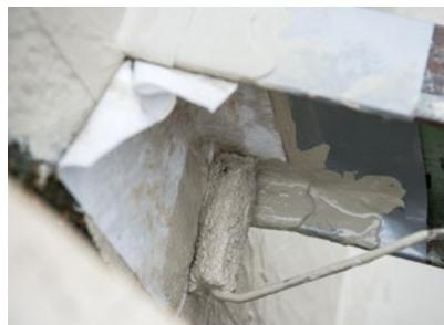
Der Vorteil des flüssigen Verarbeitens: bei der Abdichtung des Stahlträgers konnte der Träger mit dieser Abdichtung wie eine zweite Haut perfekt nachmodelliert werden.
