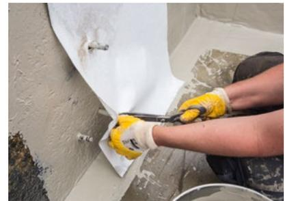
Da die Betonoberfläche Risse aufwies, wurde der gesamte Stützenkopf vliesarmiert abgedichtet. Dazu wurde Harz satt vorgelegt, das Vlies eingearbeitet und...
