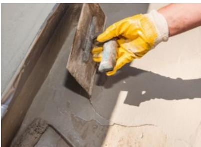
Als Schutzebene wurde ein PMMA-Verlaufmörtel auf die Abdichtungsebene aufgebracht.
