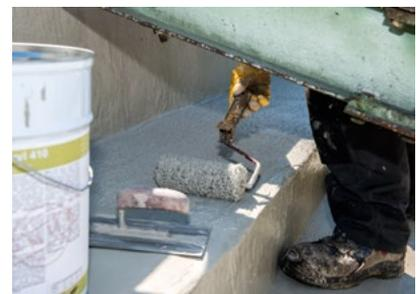
Durch nachträgliches Überrollen erzielt diese Ebene eine dauerhaft rutschfeste Oberfläche der Rutschhemmungsklasse R13.
