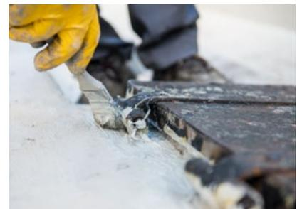
Kleinstanschlüsse wie Scharniere werden mit dem fasergefüllten Weseal in die Flächenabdichtung eingebunden.
