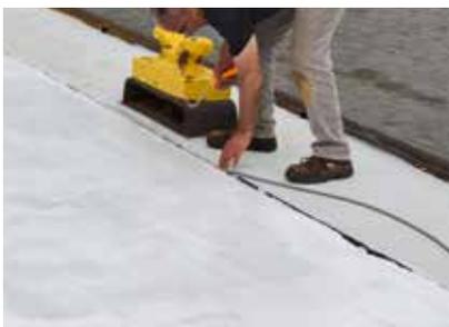
In die Bewegungsfugen zwischen den Metall- und Betonsegmenten wurden geschlossenzellige, wasserabweisende PE-Rundschnüre eingearbeitet.
