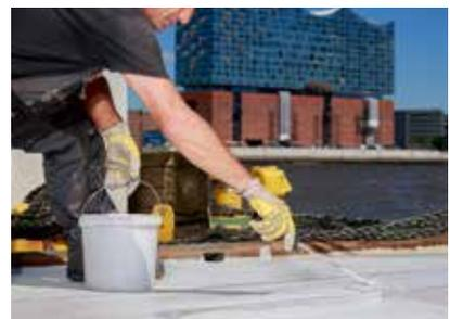
Das Abdichten der Bewegungsfugen geschah mit dem vliesarmierten Weproof Bauwerksabdichtungssystem in 3 Schritten: PMMA-Harz vorgelegt...
