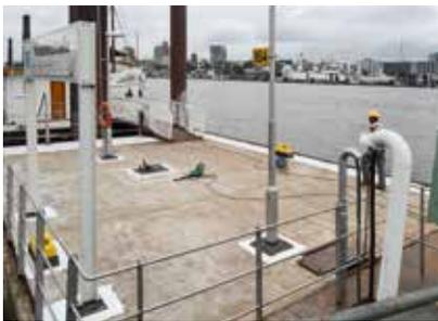
Die Oberfläche der Schwimmkörper aus hochverdichtetem Beton wurde geschliffen und gereinigt.
