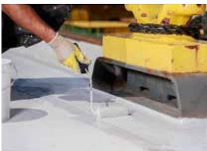
...Vliesstreifen blasenfrei eingearbeitet und mit PMMA-Harz nass-in-nass gesättigt.
