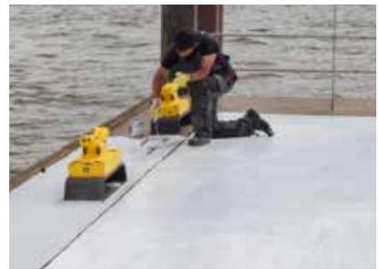
Auf sämtliche Metalloberflächen wurde nach sorgfältiger Reinigung der Metallprimer WMP 713 Primer als Grundierung aufgetragen.
