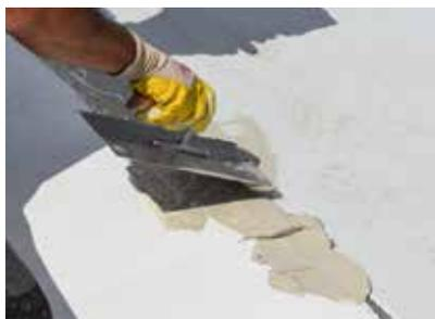
Die Hohlräume wurden mit dem ebenfalls schnell ausreagierenden PMMA-Spachtel Wecryl 810 verfüllt und egalisiert.
