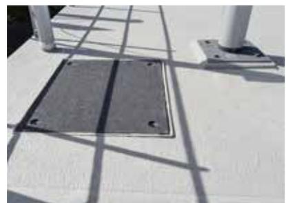
Der rutschfeste Oberflächenschutz ist dauerhaft beständig gegen Elbwasser sowie mechanische Belastungen – für sicheren Einstieg der Passagiere.
