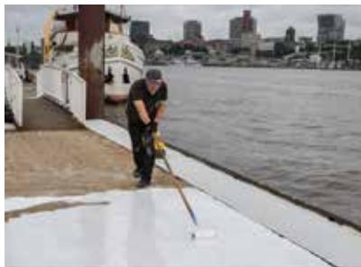
Als Grundierung kam das niedrigviskose Wecryl 122 in Weiß zum Einsatz und bildet eine geschlossene Schicht mit guter Penetration in den Beton.
