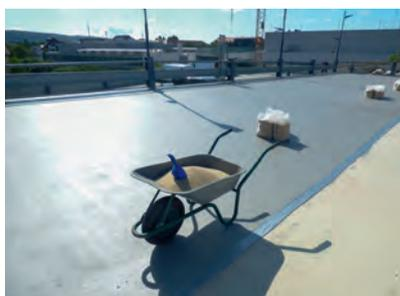
Die mit Quarzsand abgestreute Fläche generiert in Verbindung mit dem Finish Wecryl 288 eine beständige, rutschhemmende Nutzschrift.
