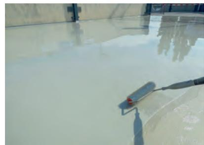
Mit dem Metall-Stachelroller wurde die jeweils frische Schicht Wecryl 279 entlüftet. Nach dem Aushärten war die Abdichtungsschicht fertiggestellt.
