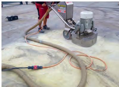
Mittels Schleifen und Fräsen wurde der Betonuntergrund für die Systemgrundierung vorbereitet.
