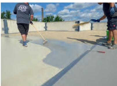
Als Schutzschicht wurde der Verlaufmörtel Wecryl 233 appliziert und mit Quarzsand der Körnung 0,7 – 1,2 mm vollflächig abgestreut.
