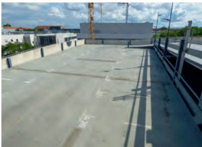
Voraussetzung für die Applikation des Oberflächenschutzsystem OS 10 – 2.0 war der rückstandslose Abtrag des Altsystems.
