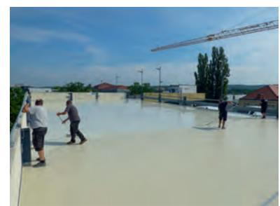
Das PMMA-Abdichtungsharz Wecryl 279 wurde mit dem Zahngummirakel in zwei Arbeitsgängen unter Einhaltung der Mindestschichtdicke aufgetragen.
