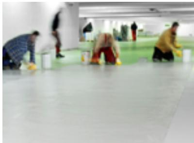
Aufziehen des mechanisch hoch beständigen Wecryl Strukturbelags per Edelstahlkelle.
