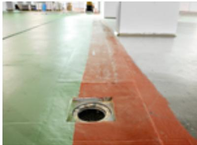
Abdichten der Detailanschlüsse an Rinnen und Bodenabläufen mit Weproof 354 und WestWood Vliesstreifen nass in nass:
