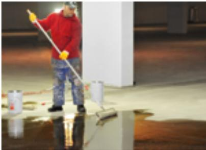
Grundieren der kugelgestrahlten Betonoberfläche mit Wecryl Primer 276.
