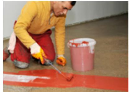
Dazu rotes PMMA-Harz vorlegen, Vliesstreifen blasenfrei einarbeiten und mit gleichem Harz sättigen.
