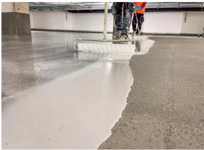
Nachdem der Untergrund vorbereitet wurde, erfolgte der Auftrag der Grundierung Wecryl 171. Dank der niedrigen Viskosität konnte die Grundierung tief in den Untergrund eindringen.
