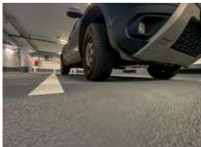
In der zweigeschossigen Parkgarage kam als Oberbelag des Oberflächenschutzsystems OS 10 – 2.0 der Strukturbelag Wecryl 410 zum Einsatz.
