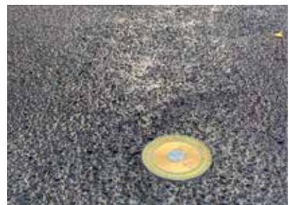
Der Bereich der Sensoren wurde ausgespart, damit Temperatur und Feuchte ständig abgeglichen werden können.
