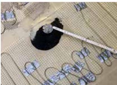
Anschließend erfolgte die Verlegung der Heizmatten. Diese wurden in den Klebe- und Armierungsmörtel Wecryl 847 eingebettet.
