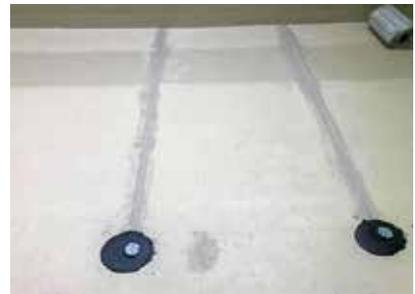
Bei der Installation der Heizebene begannen die Verarbeiter zunächst mit der Platzierung des Eis- und Schneensensors sowie des Temperatur- und Feuchtefühlers.
