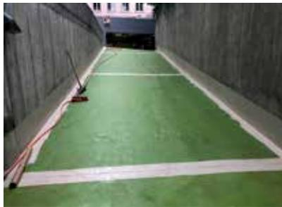
In den ersten Arbeitsgängen wurde grundiert sowie die Details abgedichtet, anschließend erfolgte der Auftrag der hauptsächlich wirksamen Oberflächenschutzschicht (hw0).
