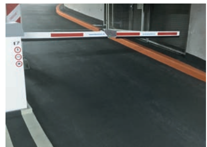
Das Oberflächenschutzsystem Wecryl OS 10 gewährleistet eine lange Lebensdauer der Ein- und Ausfahrttrampe.
