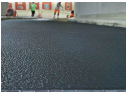
In den Strukturbelag ist werkseitig bereits eine perfekt abgestimmte Kornmatrix integriert.
