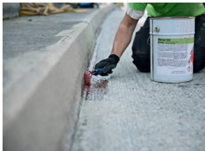
Die Grundierung wurde mit dem Fellroller gleichmäßig und filmbildend aufgerollt.
