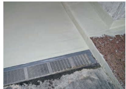
Detailanschlüsse wurden vliesarmiert abgedichtet: Das Harz wurde vorgelegt, Vlies eingearbeitet und mit Harz gesättigt.
