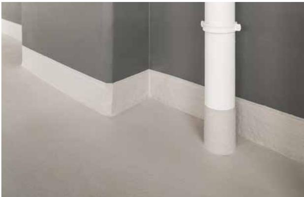
Die als schwer entflammbar klassifizierte, vliesarmierte Flüssigabdichtung schließt sämtliche Detailanschlüsse 15 cm hoch ein und bietet so einen sicheren Schutz vor Feuchtigkeit und Chlorid.
