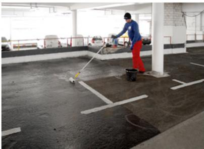
80% der Stellplätze konnten durchgehend genutzt werden, da sämtliche Arbeiten abschnittsweise erfolgten. Hier das Grundieren des kugelgestrahlten Asphalts.
