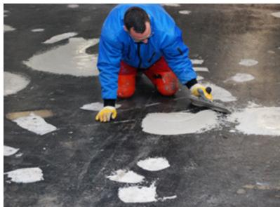
Die PMMA-Produkte konnten auch bei niedrigen Temperaturen sicher verarbeitet werden. Hier das Ausgleichen von Fehlstellen und Vertiefungen mit einem Spachtel.
