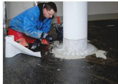
Sämtliche Detailanschlüsse, z. B. an Säulen, Bodenabläufen oder Wandaufkantungen, erhielten eine dauerhaft sichere, vliesarmierte Flüssigabdichtung.
