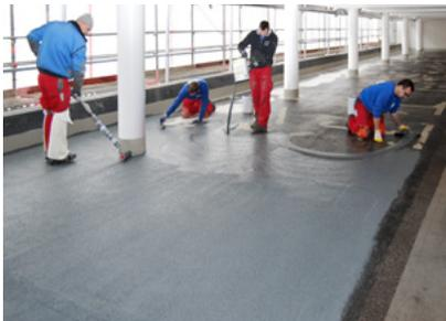
Der ca. 2 mm dicke Strukturbelag wurde zur Erzielung einer gleichmäßigen Oberfläche nach dem Auftragen abgerollt.
