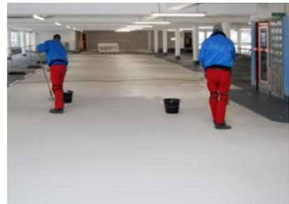
Durch das Versiegeln mit einem PMMA-Finish kommen die Farben intensiv zur Geltung und die Oberfläche lässt sich einfach reinigen.
