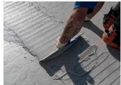
Die Einbettung der Heizschlaufen erfolgte oberflächennah - zugunsten kurzer Vorwärmzeiten und einem geringen Energieverbrauch.
