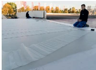
Auf die Abdichtungsebene wurden die Heizmatten verlegt und zunächst mit Steinklebeband fixiert.
