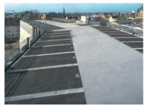
Die zwischen den Bauteilen verlaufenden ca. 70 Meter Bewegungsfugen wurden zusätzlich mit Vliesschlaufe und Fugengleitband
