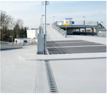
Dank der winterfesten PMMA-Produkte war der Fertigstellungstermin zum Ende Januar umsetzbar. Strukturbelag und Finish konnten bei Temperaturen von bis zu -5°C und einer relativen Luftfeuchtigkeit von bis zu 90% verarbeitungssicher aufgebracht werden.
