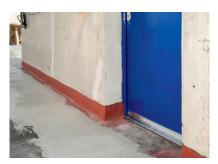
Mehr als 900 Meter Auf- und Abkantungen erhielten eine dauerhaft sichere, vliesarmierte Flüssigabdichtung.
