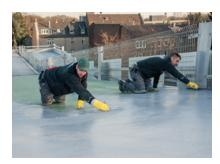
Die hier aufgebrachte, dauerhaft UV- und chloridbeständige Nutzschicht aus Strukturbelag ist sowohl höchst abrieb- als auch rutschfest.
