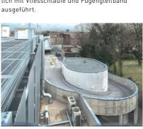
Über die Spindel wird das Parkhaus erreicht. Konstruktiv bedingt und aufgrund der Einzelhandelsgeschäfte im Erdgeschoss mit mehr als 120 sicher abgedichteten Durchdringungen wie Stützen, Bodenabläufe und Rohrdurchführungen.
