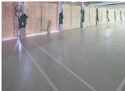
In der Fläche wurde die hwO mit Wecryl 273 ohne Vlies in zwei Arbeitsgängen realisiert und für die weiteren Arbeitsschritte abgeklebt.
