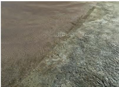
Durch Fräsen und Kugelstrahlen wurde der Untergrund für die Grundierung mit Wecryl 123 vorbereitet.
