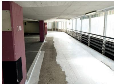
Die schnellhärtende Grundierung wurde auf den Fahrbahnen und Rampen sowie auf den Auf- und Abfahrten appliziert.
