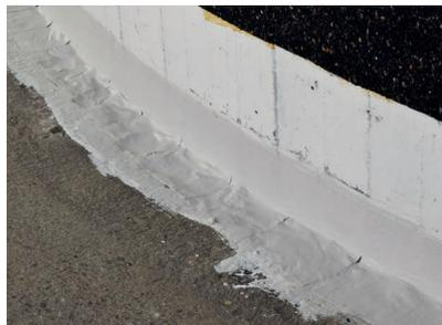
Die Detailabdichtung erfolgte vliesarmiert mit dem PMMA-Abdichtungsharz Wecryl R 230.
