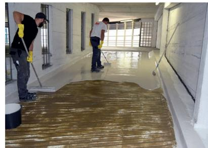
Nach der Egalisierung der Rampen wurde die erste Abdichtungslage appliziert.
