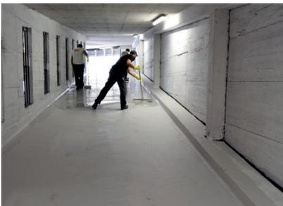
Im Anschluss wurde die zweite Abdichtungslage aufgetragen.
