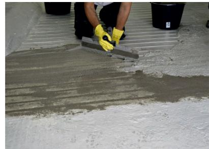
Die bestehenden Entwässerungsrillen auf den Rampen wurden mit dem flexibilisierten Verlaufmörtel Wecryl 233 egalisiert.
