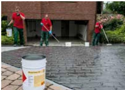
Grundieren des kugelgestrahlten und geschliffenen Verbundstein-Pflasters.
