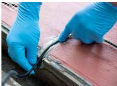
Verlegen der Zuführungs-Kabel durch die Rinne.
