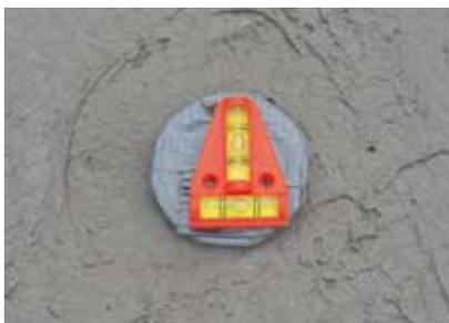
Der Sensor muss waagrecht in die Rampenheizung eingepasst werden.
