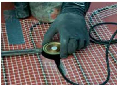
Einbauen des Feuchtigkeitsmessensors zwischen den Heiz-Schlangen.
