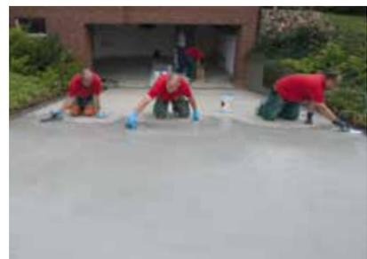
Aufziehen der Nutzebene aus mechanisch hoch beständigem Strukturbelag.
