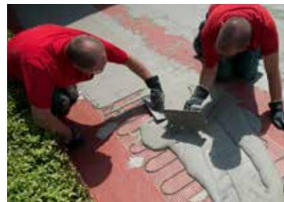
Einbetten der Heizmatten mit Verlaufmörtel.
