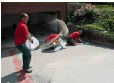
Verlegen der Schutzebene aus Verlaufmörtel plus Absandung.
