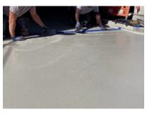
Als Nutzschicht fand der Strukturbelag West-Wood Wecryl 418 Verwendung. Der geforderte zusätzliche Abnutzungsvorrat erfolgte hierbei durch den Auftrag in zwei Arbeitsgängen.
