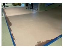
Vertiefungen in der Betonoberfläche wurden mit dem Kratzspachtel Wecryl 123 K gefüllt.
