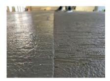
Der Gesamtverbrauch des Wecryl 418 beläuft sich auf ca. 120 % (links: fertige Nutzschicht mit 2-fachem Auftrag; rechts: 1-facher Auftrag vor der weiteren Überarbeitung).
