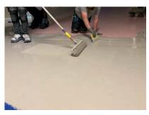
Die dynamisch rissüberbrückende hw0, bestehend aus WestWood Wecryl 271, wurde mittels Zahnkamm aufgetragen und im Nachgang entlüftet.
