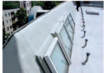
Auch Anschlüsse an Kunststoffprofilen, wie z.B. Dachflächenfenstern, können sicher flüssig eingebunden werden.
