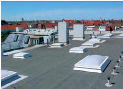
Bitumenbahnen wurden überarbeitet und befestigt. Nach der Reinigung konnte ohne Grundierung direkt beschichtet werden.
