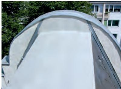
Flüssigkunststoff haftet funktionsgerecht auf fast jedem Untergrund. So konnte auch die Gaube oberseitig abgedichtet werden.
