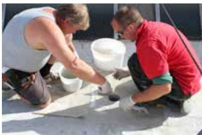
4. Die Gullis wurden ersetzt und mit Wecryl 230 mit Vlieseinlage dauerhaft abgedichtet.
