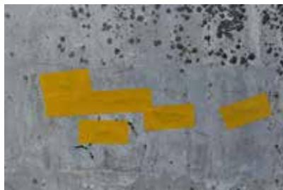
2. Die schadhaften Bereiche der Kunststoffdichtungsbahn (Risse) wurden mit Gewebeklebeband entkoppelt, um das Eindringen des PMMA-Harzes in den Dachaufbau zu verhindern.
