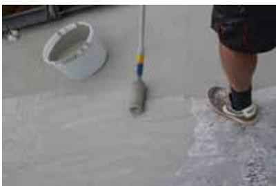
5. Die horizontale Fläche wurde mit Wecryl 230 und Vlieseinlage abgedichtet. Für die Vertikale wurde Wecryl 230 thix und Vlieseinlage verwendet.
