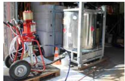
3. Durch die Anlieferung des Abdichtungsharz Wecryl in Containern, konnte das PMMA-Harz über eine Pumpe auf die Dachfläche befördert werden.
