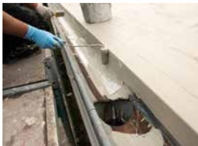
Der Anschluss an die Rinne erhielt nach dem Anbringen eines Fugengleitbandes am Übergang zum Traufblech ebenfalls die vliesarmierte Flüssigabdichtung.
