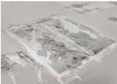
Die alte Dachdichtungsbahn war teilweise verwittert und wies erste Undichtigkeiten an Nähten und Detailanschlüssen auf.
