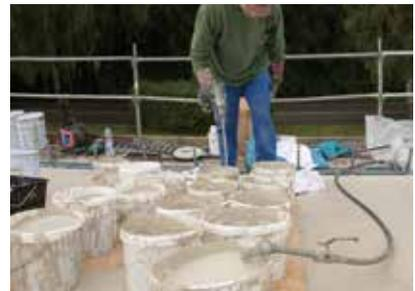
Für eine optimale Baustellen-Logistik sorgte eine Pumpe. Mit ihrer Hilfe gelangte das PMMA-Harz direkt zum Mischplatz auf der Dachfläche.
