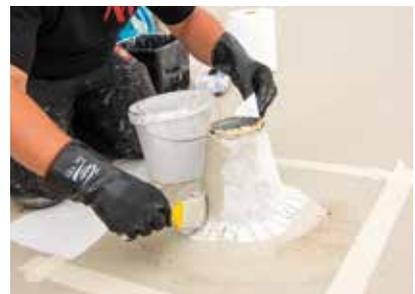
Auch geometrisch schwierige Anschlüsse, wie der konisch zulaufende Lüfter, wurden nach dem gleichen Prinzip sicher abgedichtet: hier das Sättigen des Vlieskragens mit PMMA-Harz.
