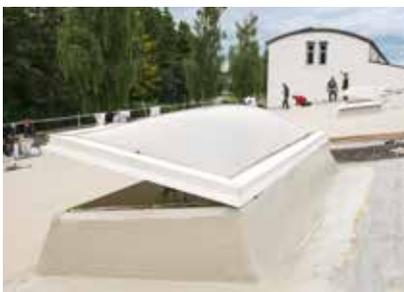
Die Lichtkuppel ist in die Flächenabdichtung perfekt eingebunden. Die gute Haftfähigkeit des PMMA macht mechanische Befestigungen überflüssig und erspart spätere Wartungskosten.
