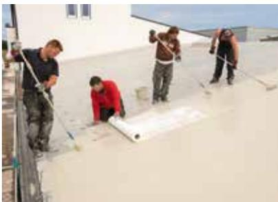
Das gesamte Flachdach wurde vliesarmiert abgedichtet: PMMA-Harz vorgelegt, Vlies eingearbeitet und mit PMMA-Harz gesättigt.
