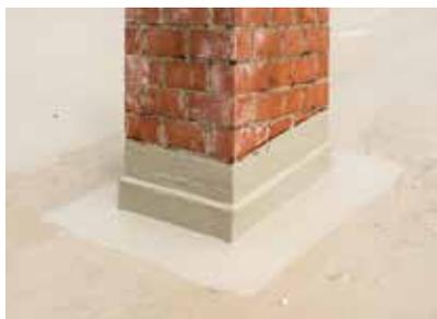
Saugende Untergründe wie das bestehende Mauerwerk müssen grundiert werden. So haftet die Flüssigabdichtung auch an diesem Schornstein dauerhaft sicher.
