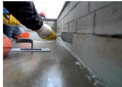
Mit dem flexiblen, bis 0 °C verarbeitbaren Spachtel Wecryl 810 wurden kleine Unebenheiten an den Aufkantungen und Fugen egalisiert.
