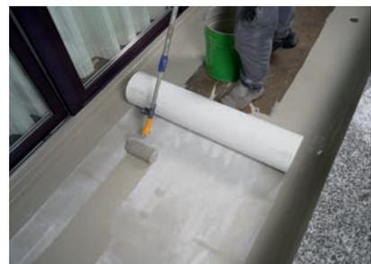
Auf der Bodenfläche kam die vliesarmierte Flüssigabdichtung Wecryl R 230 zum Einsatz und sorgte für eine nahtlose Flächenabdichtung.
