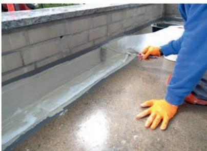
Detailanschlüsse wie Aufkantungen erhielten eine vliesarmierte Flüssigabdichtung mit Wecryl R 230 thix.
