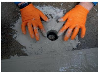
Ebenso wie die Aufkantungen erhielten auch die Bodenabflüsse eine vliesarmierte Flüssigabdichtung.
