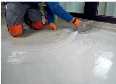
Der Verlaufmörtel bildete die Schutzschicht der Abdichtung. Er wurde mit der Aufstreichkelle mit Dreieckzahnleiste aufgebracht.
