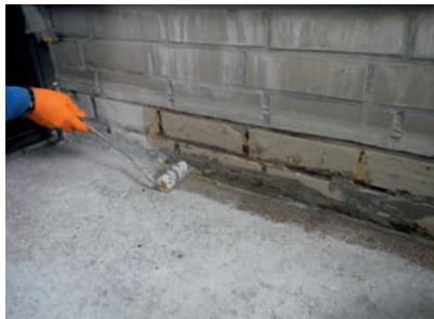
Die schnellhärtende Grundierung Wecryl 276 bildete auf dem vorbehandelten Untergrund die Basis für die Abdichtungsschicht.
