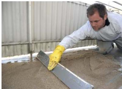
Auf der grundierten Fläche gleicht der Fachverleger das Kontergefälle mit einem Cryl-Mörtel aus. Nach nur einer Stunde geht es weiter.
