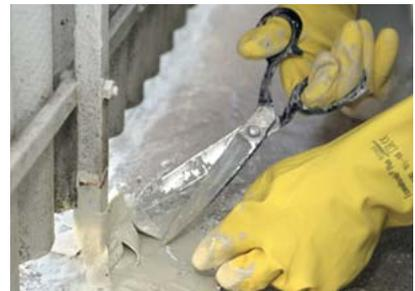
Die Geländerstützen bleiben erhalten. Sie werden mit Vlies und dauerhaft flexiblen PMMA-Harzen sicher abgedichtet.
