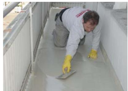
Die Schutzschicht besteht aus einem Verlaufmörtel (Harz-Quarzsand-Gemisch). Sie sorgt dafür, dass Punktlasten z.B. von Stühlen verteilt werden.
