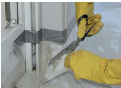
Der Fachverleger schneidet das Vlies für den Türanschluss passend zu.
