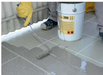
Auftragen der zweiten Finish-Schicht im Farbton der Fliesen und Einblasen der Chips.
