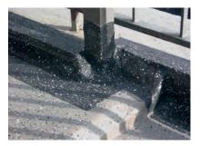
Sämtliche Durchdringungen sind, wie alle anderen Detailanschlüsse, dauerhaft sicher abgedichtet.
