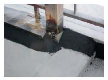
Die Hohlräume an den Sockeln und Metallstützen wurden auch mit dem Wecryl 242 angearbeitet.
