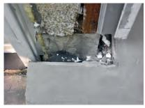
Hohlräume an den aufgehenden Bauteilen wurden mit Bituperl verfüllt und mit einer ca. 2 cm dicken, begehbaren Schicht aus Wecryl 242 flächenbündig aufgefüllt.
