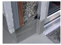
Sämtliche Anschlüsse an den aufgehenden Bauteilen wurden mit dem vliesarmierten Wecryl Abdichtungssystem dauerhaft sicher
