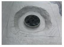
Die alten einbetonierten Bodenabläufe wurden ca. 3 cm tief freigestemmt und mit dem vliesarmierten Wecryl Abdichtungssystem dauerhaft sicher abgedichtet.
