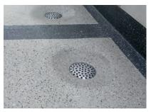
So sind die Bodenabläufe optisch ansprechend und sicher in die Flächenabdichtung eingebunden.
