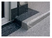
Selbst die komplizierten Anschlüsse an den Kunststoff-Türrahmen sind perfekt abgedichtet worden.
