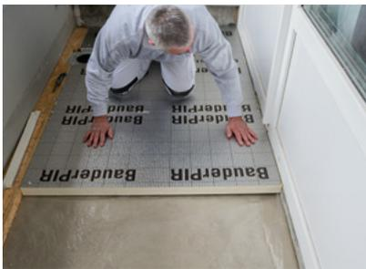
Zur Wärmedämmung wurden sehr effiziente, 50 mm dicke PU-Hartschaumplatten (WLS oder  $\lambda$  024) mit beidseitiger Aluminium-Deckschicht eingebaut.
