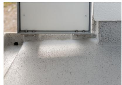
So entstand eine zugleich trittsichere sowie pflegeleichte Oberfläche auf dem komplett schwer entflammbaren Aufbau aus Wärmedämmung und Balkonabdichtung.
