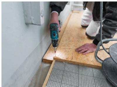
Mittels der Lastverteilschicht aus ebenfalls schwer entflammbaren OSB/3-Platten wurde eine Rinne vor der Brüstung ausgebildet.
