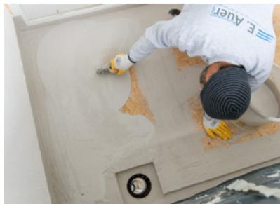
Auf der Fläche kam die vlieslose Flüssigabdichtung aus dem Weproof-Programm zum Einsatz. Als erstes wurde die Flexschicht aufgetragen,...
