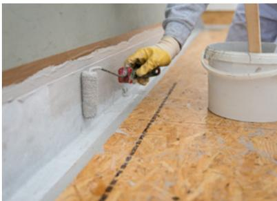
Alle Detailanschlüsse wie die Rinne an der Wandaukantung, Bodenabläufe, Fugen, etc. erhielten eine vliesarmierte Flüssigabdichtung.
