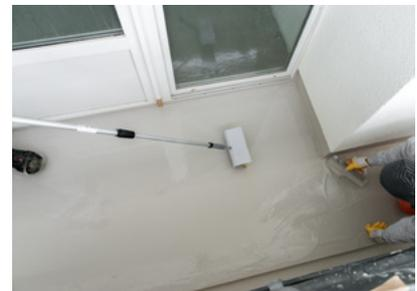
...als zweites die Fixschicht appliziert. Dieses Abdichtungssystem überbrückt Bewegungen von bis zu 1 mm dauerhaft und sicher - zertifiziert durch ein abP.
