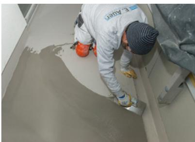
Die Schutzebene aus dem mit Quarzsand abgestreuten „Weproof 527 Verlaufmörtel“ ist ebenfalls als schwer entflammbar klassifiziert (Cfl-s1).
