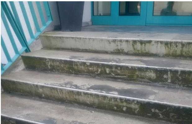
Die Edelstahltreppe vor der Sanierung. Die stark abgenutzte alte Epoxidharzbeschichtung musste komplett abgeschliffen werden.
