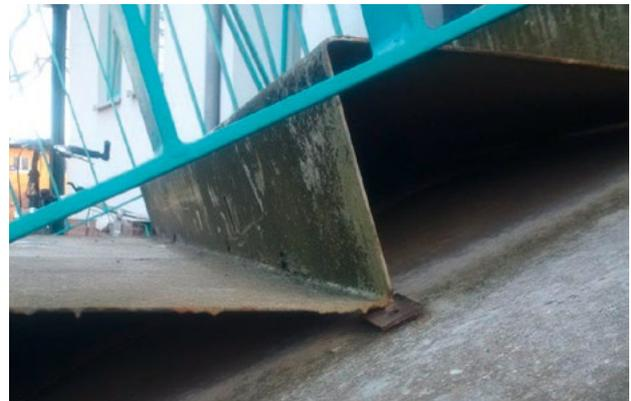
In der Nacht wurde die vorbereitete Treppe mit dem Metallprimer WMP 713 grundiert und danach die Rollbeschichtung Wecryl 420 aufgetragen.
