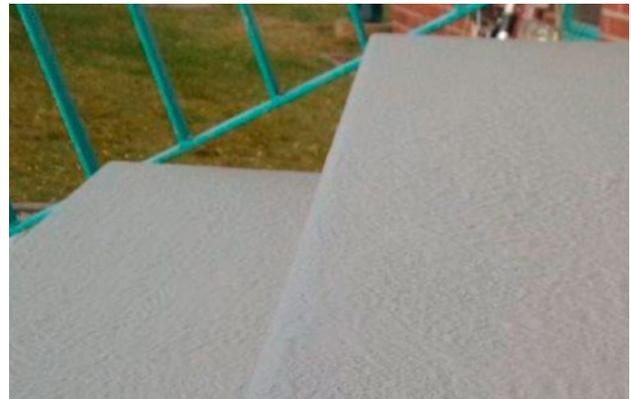
Die integrierte Quarzsandmischung macht die Rollbeschichtung zu einem hoch abriebfesten und rutschfesten Langzeitbelag.
