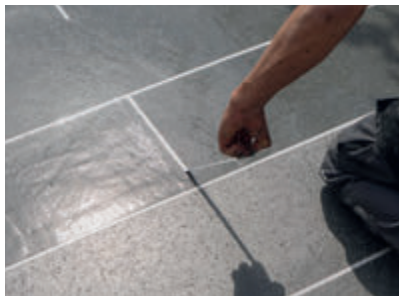
Das Abziehen der Fugen-Klebebänder machte die großzügige Fliesenoptik sichtbar.
