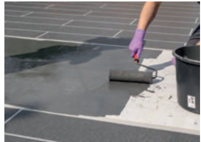
Auf die erste, helle Finish-Schicht Wecryl 288 wurde mithilfe von Feinkreppband das Fliesenmuster aufgebracht. Anschließend wurde die zweite, deutlich dunklere Schicht des Finish aufgetragen.
