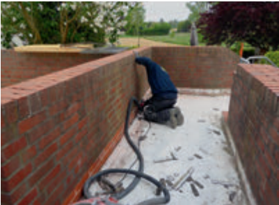
Der Estrichuntergrund wurde sorgfältig bis in die Detailbereiche geschliffen und für das PMMA-System vorbereitet.
