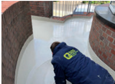
Als Schutzschicht der Abdichtung dient der Verlaufmörtel Wecryl 233.
