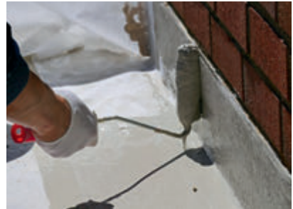
Detailschlüsse wie Aufkantung und Geländerstützen erhielten eine vliesarmierte Flüssigabdichtung mit Wecryl R 230 thix.
