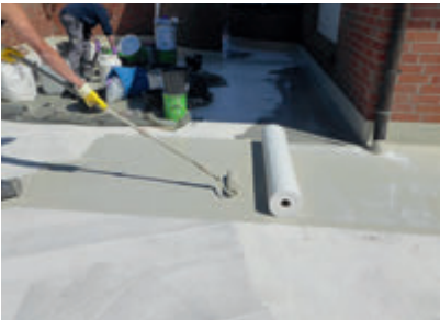
Auch auf der Terrassenfläche kam die vliesarmierte Flüssigabdichtung zum Einsatz.
