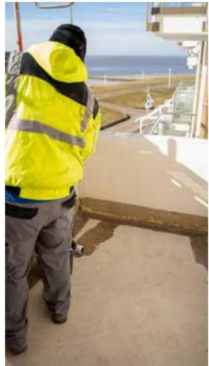
Die Grundierung Wecryl 171 wurde an den Aufkantungungen und in der Fläche appliziert. Sie bildete auf dem stark saugendem Untergrund die Basis für die Abdichtung.
