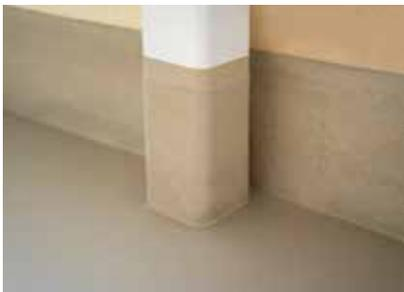
Detailanschlüsse wie Aufkantungungen erhielten eine vliesarmierte Flüssigabdichtung mit Wecryl R 230 thix.
