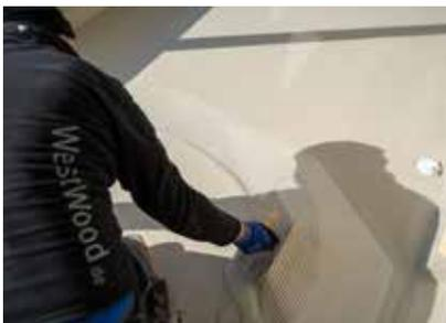
Der flexibilisierte Verlaufmörtel Wecryl 337 wurde als Schutzschicht oberhalb der Abdichtungsebene eingesetzt.
