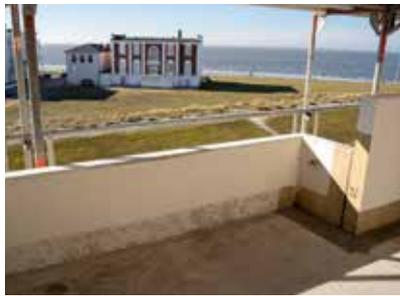
Der neu verlegte Estrich wurde sorgfältig bis in die Detailbereiche geschliffen, anschließend abgesaugt und somit für das PMMA-System vorbereitet.
