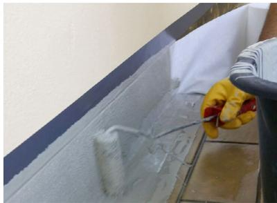
Sämtliche Detailanschlüsse an Türen, Speier, Wand und Fugen wurden dauerhaft sicher vliesarmiert abgedichtet: PMMA-Harz vorgelegt, Vlies eingearbeitet, mit PMMA-Harz gesättigt.
