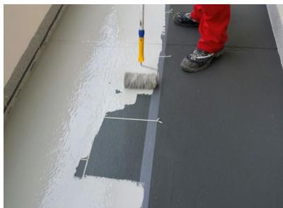
Im Anschluss daran wurde die hellere Versiegelung aufgetragen und mit dekorativen Chips abgestreut. Durch das Entfernen der Fugenbänder entstand die Fliesenoptik.
