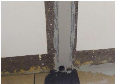
Die Bewegungsfugen auf den Flächen und in den Brüstungen wurden freigelegt und mit flexiblem PMMA-Spachtel egalisiert; Fehlstellen vor den Speiern mit PMMA-Mörtel verfüllt.
