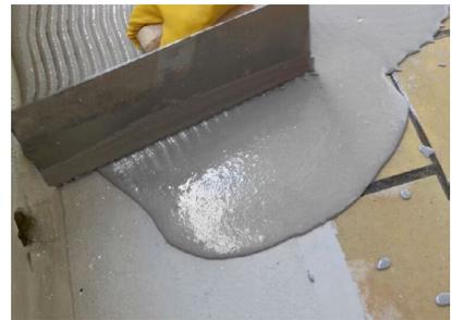
Auf die geschliffenen und grundierten Fliesen brachten die Fachverleger eine Schutzebene aus PMMA-Verlaufmörtel (Harz-Sand-Gemisch) auf.
