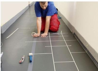
Die Nutzebene baute sich aus zwei Schichten PMMA-Finish auf. Auf der ersten, dunkleren Schicht wurde das Verlegemuster exakt abgelebt.
