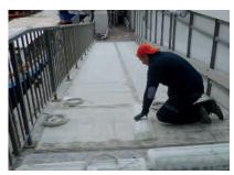
Auf den Rampen und Treppen wurden die Heizmatten dem Verlegeplan entsprechend verlegt und zunächst mit Klebeband fixiert.
