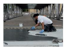
Als Nutzschicht für extrem stark belastete und hoch frequentierte Nutzflächen ist der Strukturbelag Wecryl 410 bestens geeignet.
