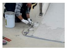
Zugunsten kurzer Vorwärmzeiten und einem geringen Energieverbrauch erfolgt die Einbettung der Heizschlaufen stets oberflächennah.
