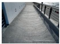
Die Kombination aus Heizmatten und dem hoch abrieb- und rutschfesten Strukturbelag sorgt zukünftig für einen stets sicheren Halt.
