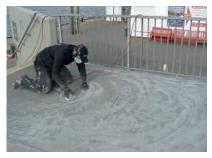
Die alte Beschichtung musste aufgrund der massiven Beschädigungen mittels Schleifen komplett entfernt werden.
