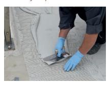
Nach der Ausrichtung der Heizmatten wurden diese mit dem Wecryl 847 Klebe- und Armierungsmörtel vollständig eingebettet.
