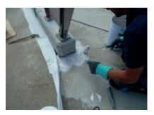
Die Detailanschlüsse wurden vliesarmiert mit dauerhaft flexiblem Wecryl R 230 thix abgedichtet.
