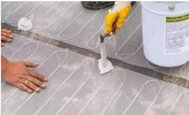
Heizebene Die Netzheizmatten werden gem. Verlegeplan auf der hw0 ausgerichtet und fixiert, der Kaltleiter angeschlossen
