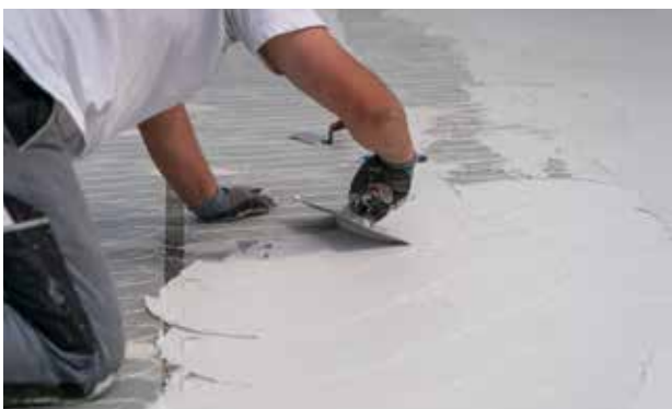
Einbettschicht Mit dem Klebe- und Armierungsmörtel Wecryl 847 werden die Netzheizmatten in den Aufbau integriert
