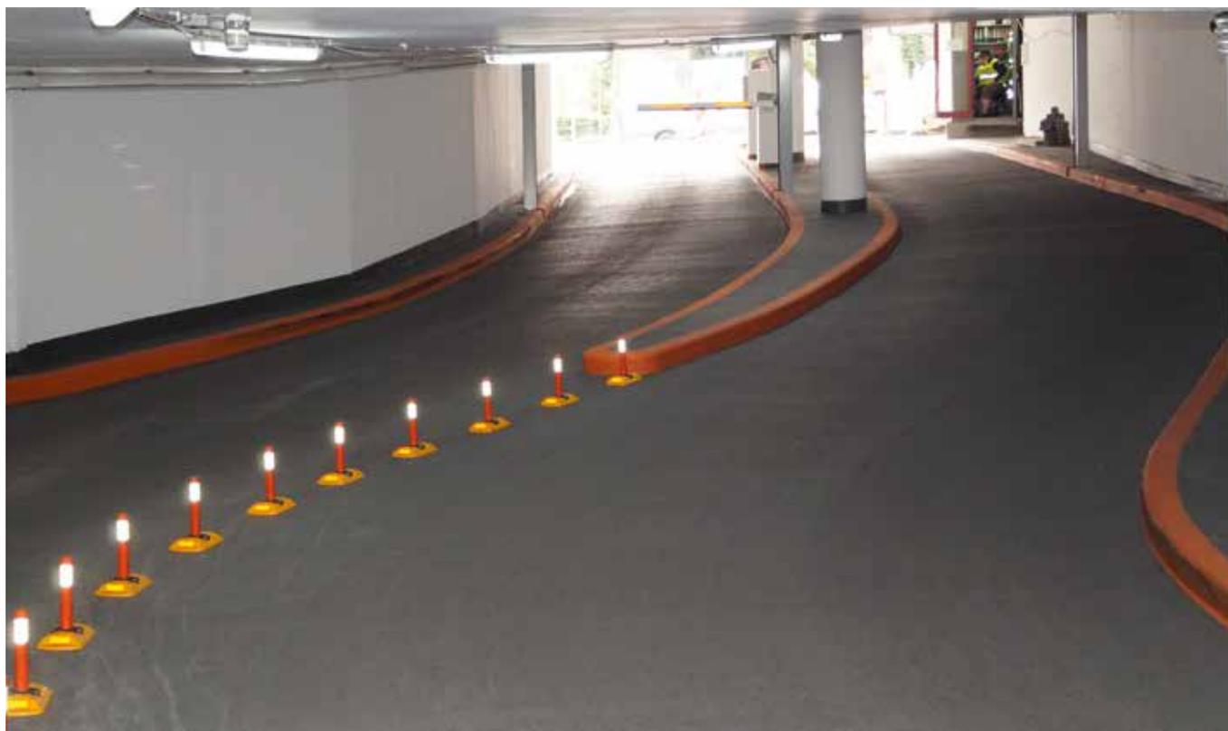
Beschichtung mit erhöhter dynamischer Rissüberbrückungsfähigkeit für begehbare- und befahrbare Flächen.
