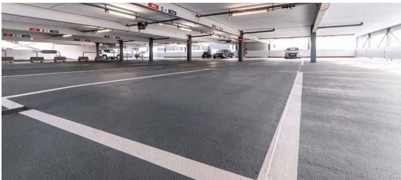
Beschichtung als Dichtungsschicht mit hoher Rissüberbrückung unter Schutz- und Deckschichten für begehbare und befahrbare Flächen
