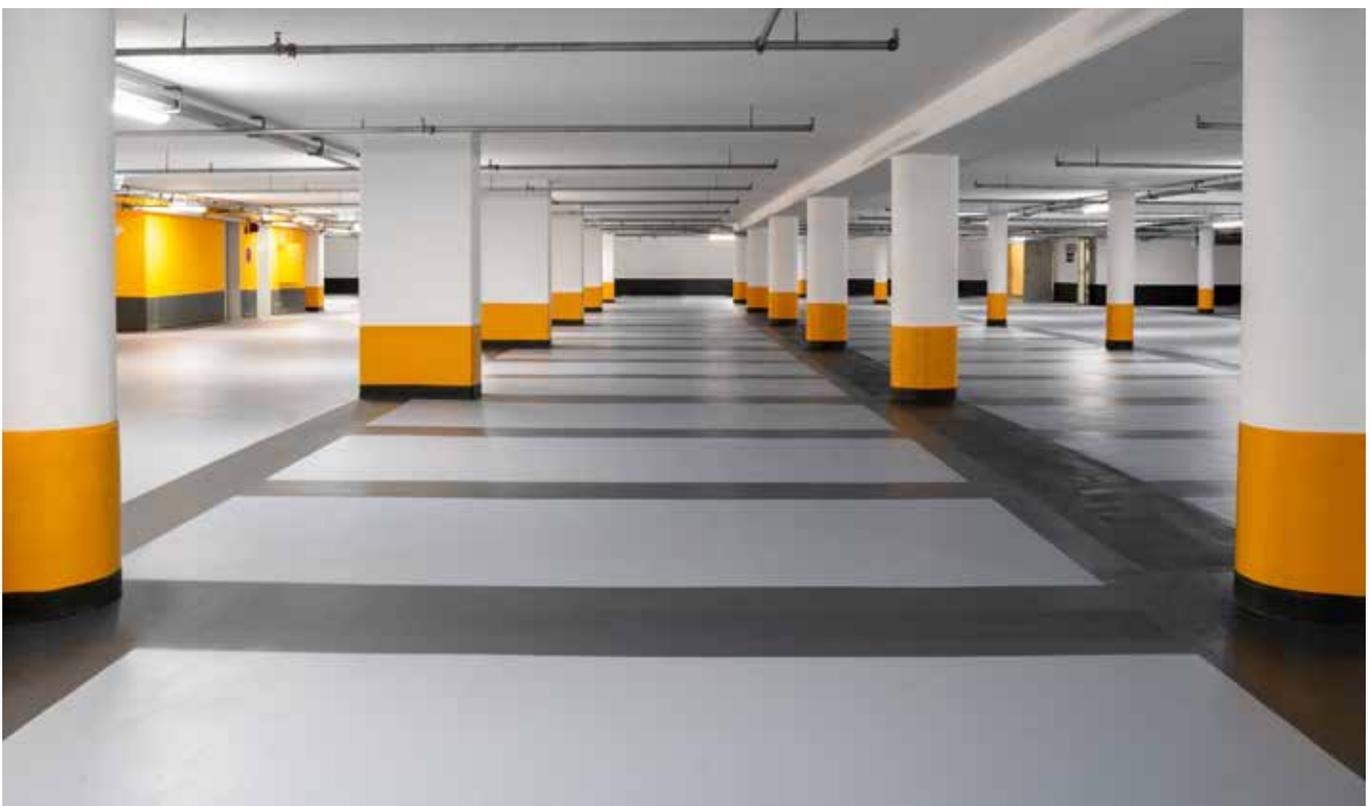
Starre Beschichtung für befahrbare, mechanisch stark belastete Flächen
