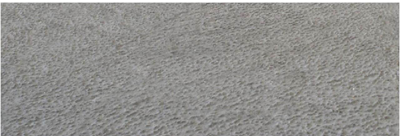
Strukturbelag mit Glättspachtel aufgebracht und anschließend abgerollt
