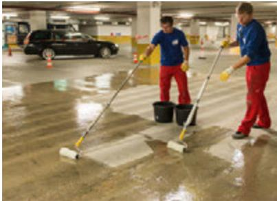
**Grundierungsebene** auf den Untergrund abgestimmte Grundierung auftragen
