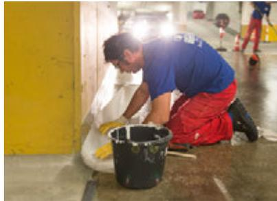
**Abdichtungsebene** Detailanschlüsse vliesarmiert abdichten, Harz vorlegen – Vlies einarbeiten – mit Harz sättigen.
