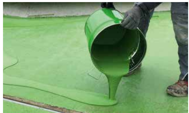
Reprofilieren Kratz- und Ausgleichspachtelung bedarfsweise mit Wecryl 123 K
