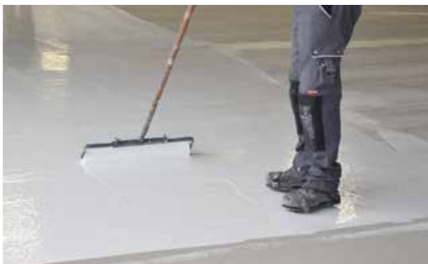
Grundierungsebene auf den Untergrund abgestimmte Grundierung auftragen, ggf. Untergrundverfestiger Wecryl 821 verwenden
