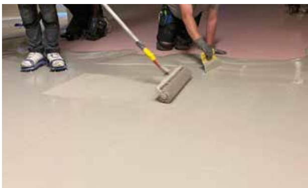
rissüberbrückende Beschichtung Wecryl 271 beim Aufbau OS 11b applizieren und im Nachgang entlüften
