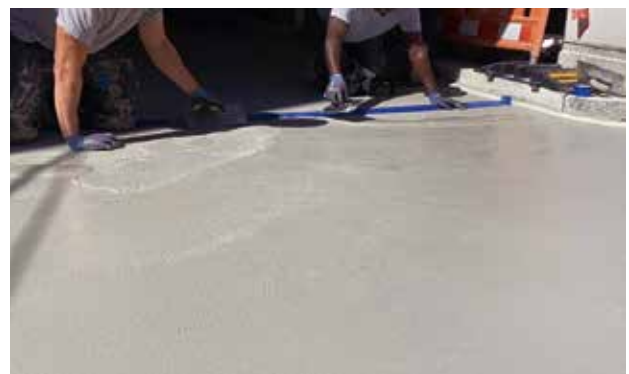
Nutzschicht Wecryl 419 wird als einheitlicher Oberbelag der beiden OS-Systeme in lediglich einem Arbeitssgang aufgetragen
