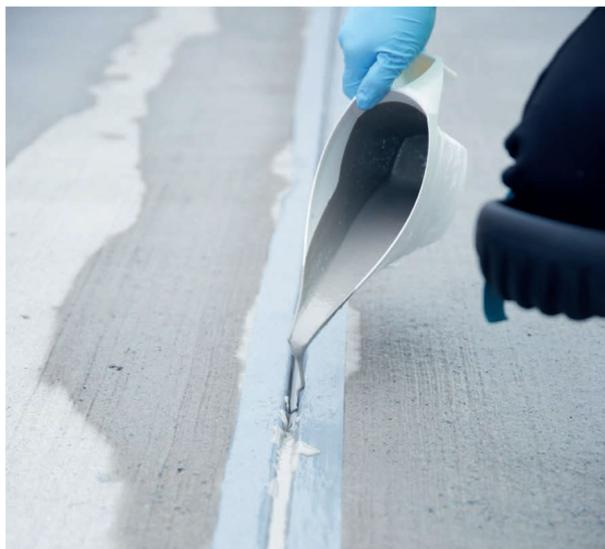
*Abb. 1: Die langlebige Wecryl 813 Vergussmasse auf PMMA-Basis lässt sich bei besten Haftungseigenschaften ohne vorherige Grundierung applizieren.*
