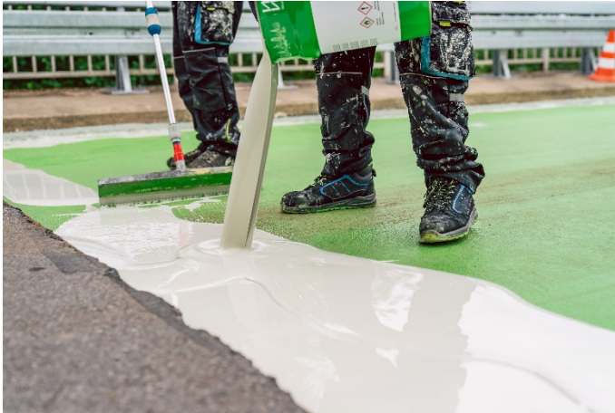
Bildunterzeile 3: Das leistungsfähige Abdichtungsharz wird einlagig appliziert, was zu optimierten Verbräuchen führt
