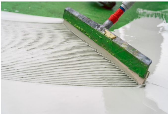
Bildunterzeile 4: Der Zahngummimirakel sorgt dafür, dass die geforderten Schichtdicken eingehalten werden.
