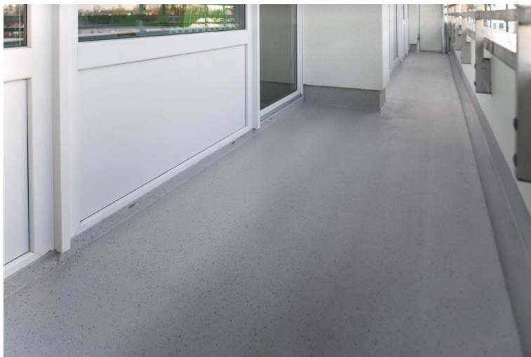
Abb 2: Ästhetisch, trittsicher und pflegeleicht präsentiert sich die flammhemmende PMMA-Oberfläche.
