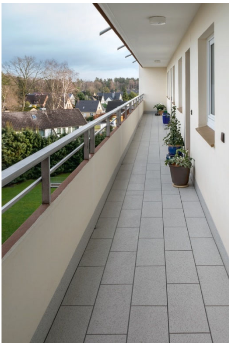
Abb. 1: Bodenbeläge von Laubengängen müssen hohe Brandschutzanforderungen erfüllen.
