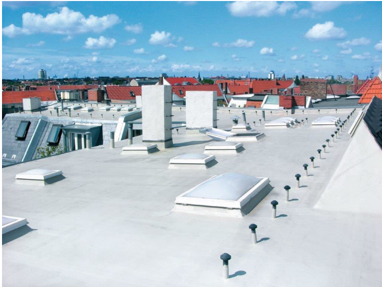
Abbildung 3: Kühles, weißes PMMA-Dach mit höchsten Brandschutz-Qualitäten
