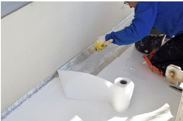
*Abb. 1: Die Vlieseinbettung sorgt für die dauerhafte Abdichtung sämtlicher Anschlüsse.*
