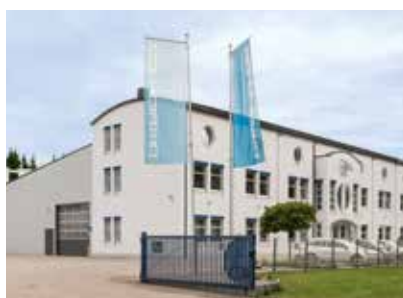
Flachdach einer Industriehalle in Schwabmünchen
