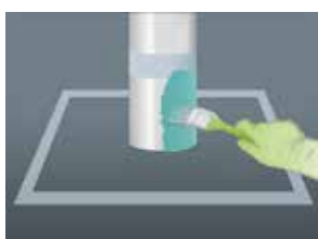
Passende Grundierung auftragen
