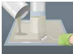
Rohrkragenmanschette sättigen
